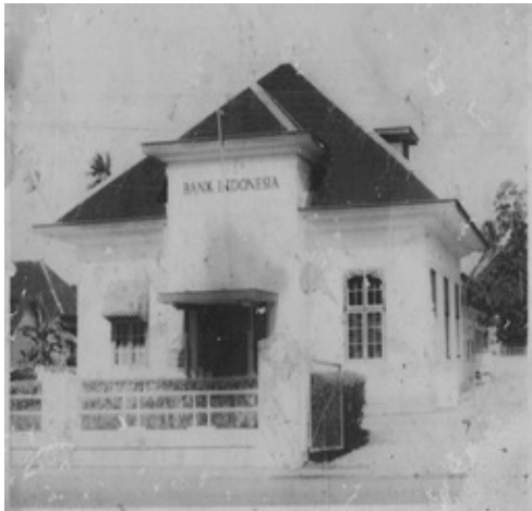
Gambar 4. Bank Indonesia Banjarmasin Jl. Pangeran Samudra
